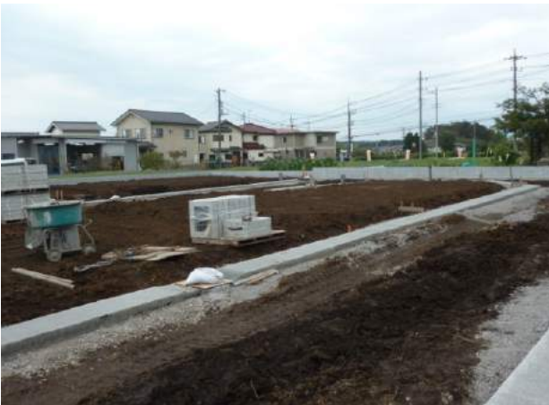
埼玉県所沢市の造成地
