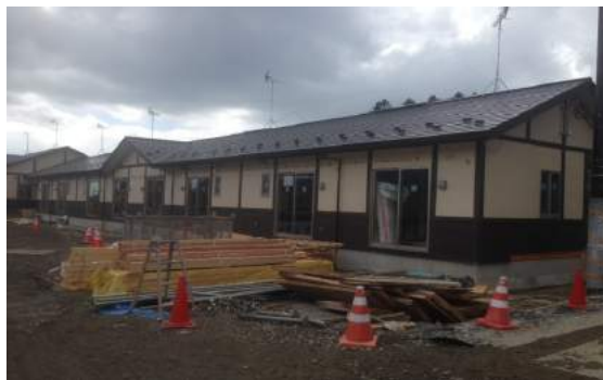
野蒜北部丘陵地区災害公営住宅 (建設中)
