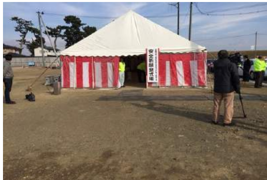
第一期の建設工事開始(2015年12月) (名取市HPより)
